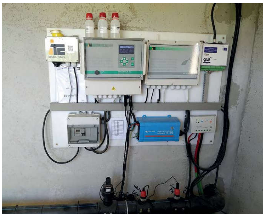
Capçal de reg amb el programador, el sensors de cabal, pH i conductivitat. Foto: IRTA.
