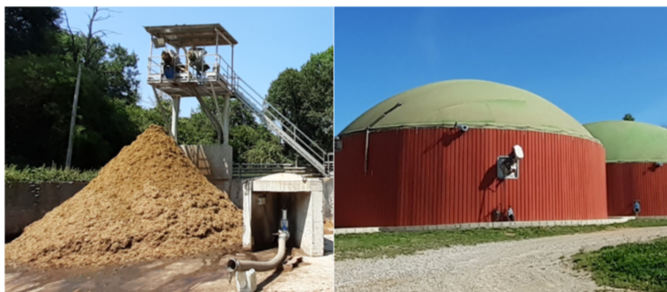
Figura 1.- Separador sòlid-líquid (esquerra) i digester (dreta), sistemes de tractament de dejeccions ramadera per reduir-ne el contingut en nutrients.
