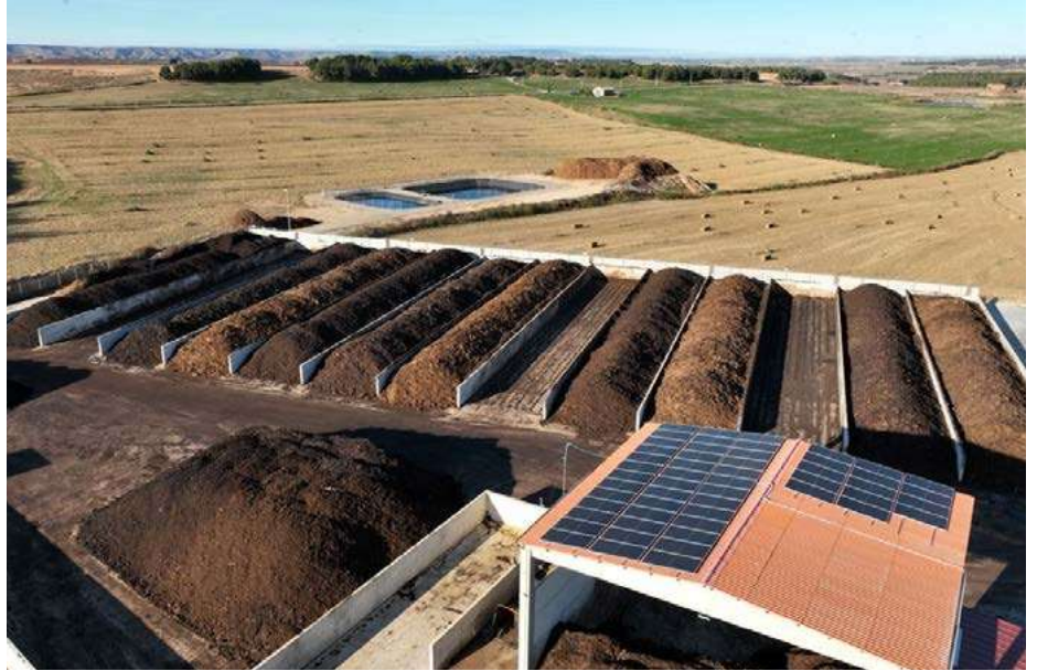
Planta de compostatge. Foto: Alcarràs Bioproductors, SAT.
